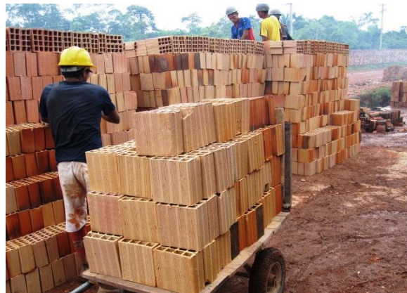
Figura 22 – Trabalhador empilhando tijolos
