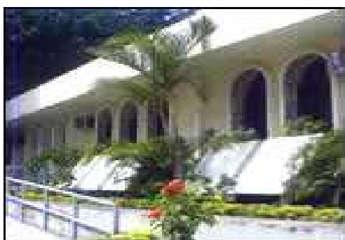
Figura 13: antigo prédio do MISAM ao lado do Palácio Rio Negro, hoje demolido. Fonte: http://www.bv.am.gov.br/diacultura/misam.php
