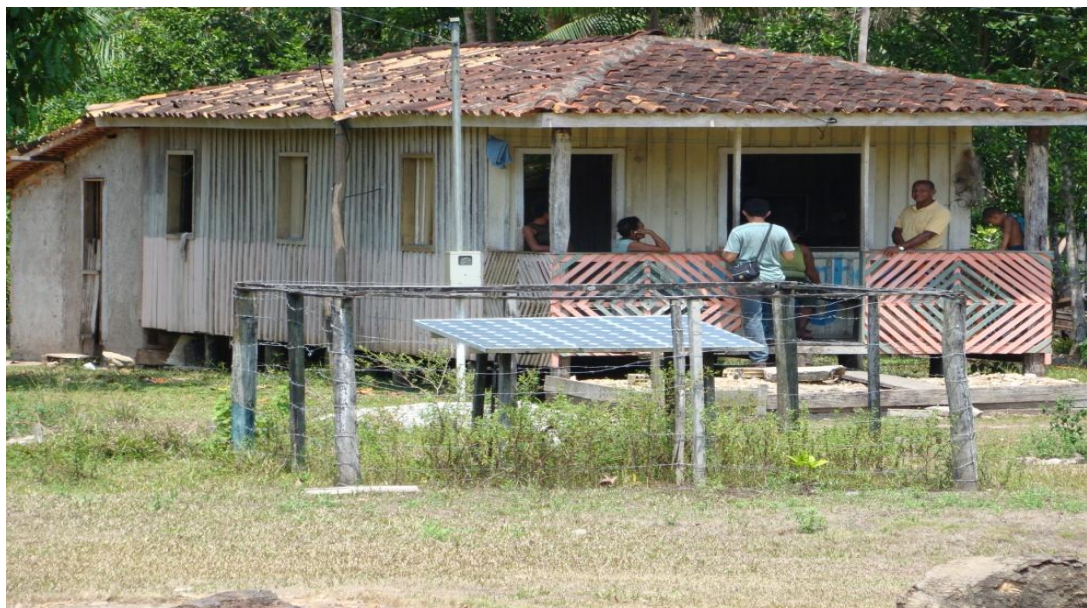
Figura 7: Placa Fotovoltagem para geração de eletricidade doméstica
