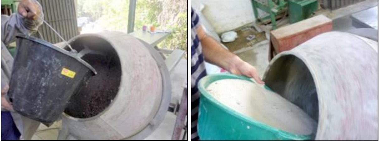
Figura 20 - Colocação dos materiais na betoneira.
