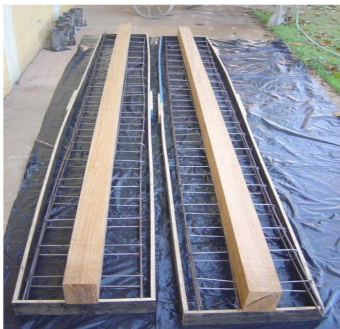
**Figura 53:** Posicionamento das vigas para a concretagem.
