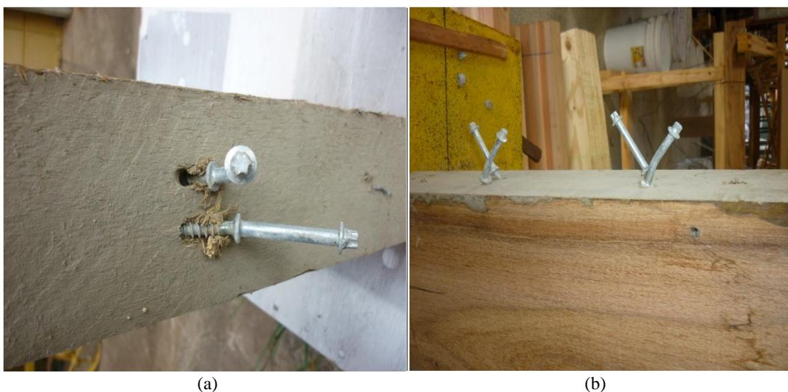
**Figura 65:** Embutimento do conector na madeira.
