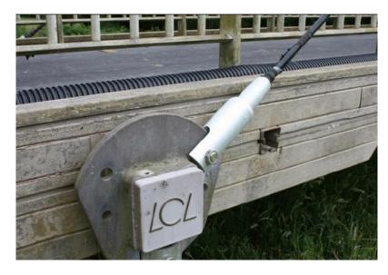
Figura VI.5 – Ancoragem dos estais nas transversinas principais do tabuleiro da passarela (Fonte: Stratford, 2012)
