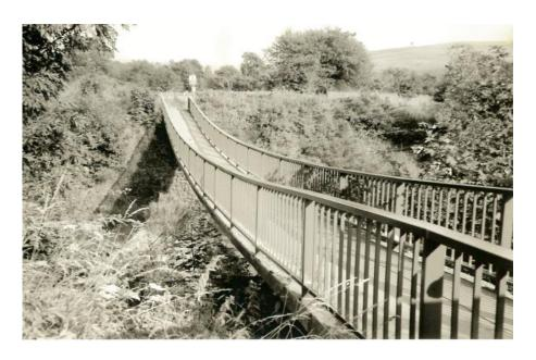
Figura I.5 – Passarela na forma de lâmina em catenária, próxima a Sheffield, Inglaterra (Fonte: Zivanovic, 2006)
