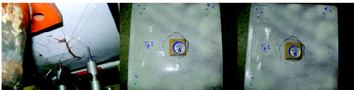
Figura A4i. Vista inferior e superior da placa, após o término do ensaio, visualizando-se fissuras concêntricas.
