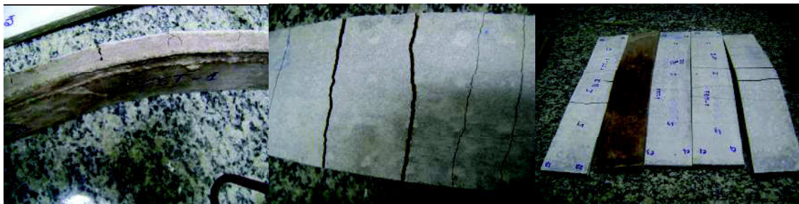
Figura A2e. Mapa das fissuras nas placas após conclusão dos ensaios.
