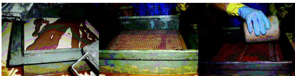
Figura A3b. Distribuição da argamassa e das telas da fibra vegetal de arumã .
