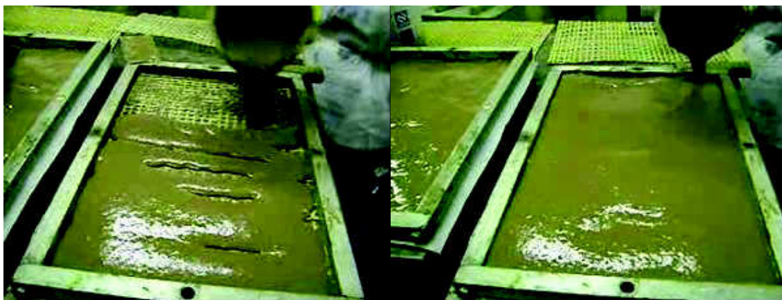
Figura 36. Terceira camada, adição de argamassa.
