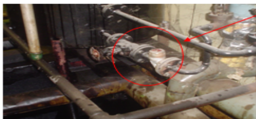
Drenagem do tanque de óleo BPF
