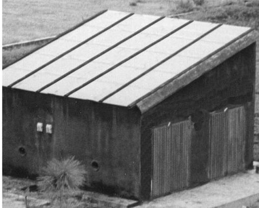
Figura 27: Secador Solar de Madeira com capacidade de  $8\text{m}^3$ .
