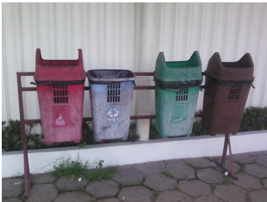
Figura 30: Suportes de lixeira seletiva corroídos pela ação do tempo.
