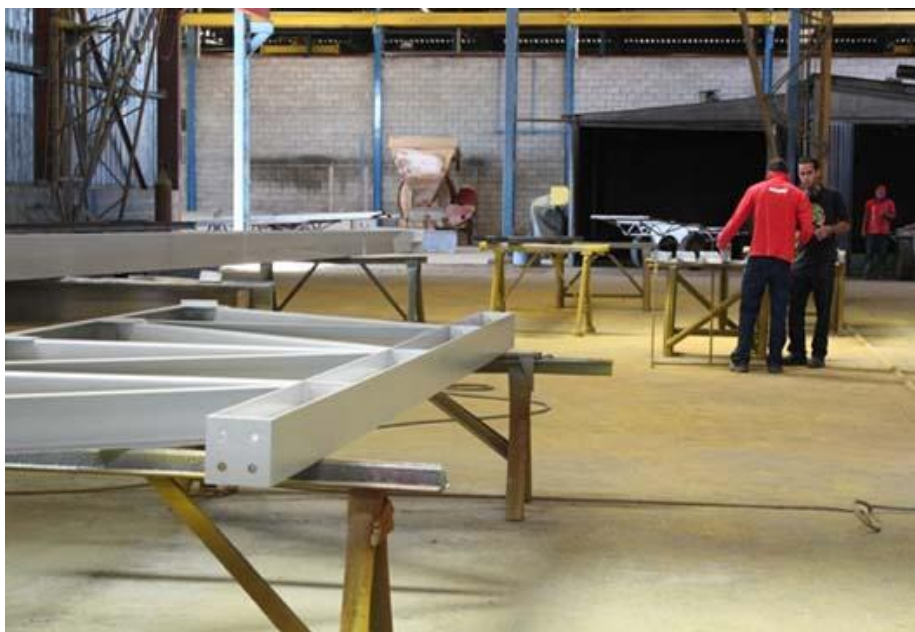
Figura 20: Setor de limpeza das chapas para pintura.
