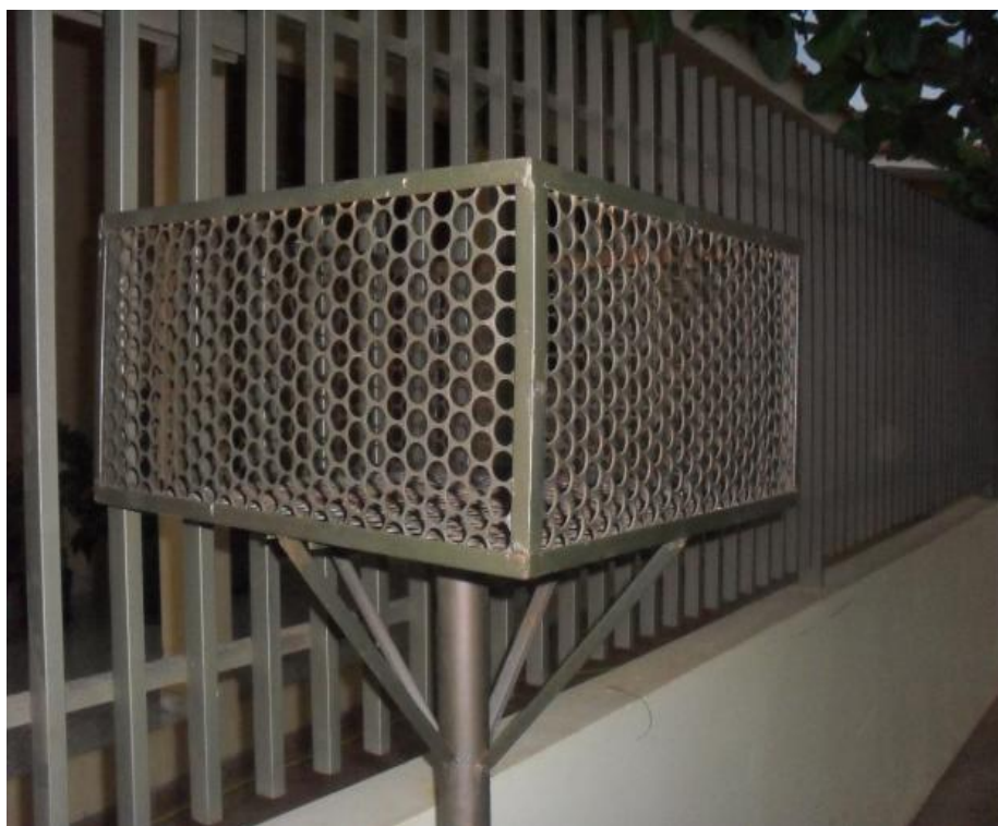
Figura 32: Modelo de lixeira para calçada confeccionada com sobras de chapa. Fonte: Fotografia tirada em abril de 2013, Zona Sul, Manaus.
