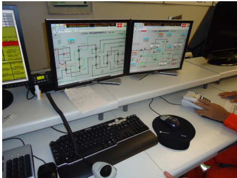
Figura 24 – Console de operação utilizada para a medição de desempenho Fonte: o autor durante a coleta de dados
