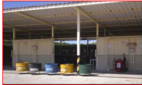
Foto 5: Novo depósito para resíduos classe I (estruturado).
