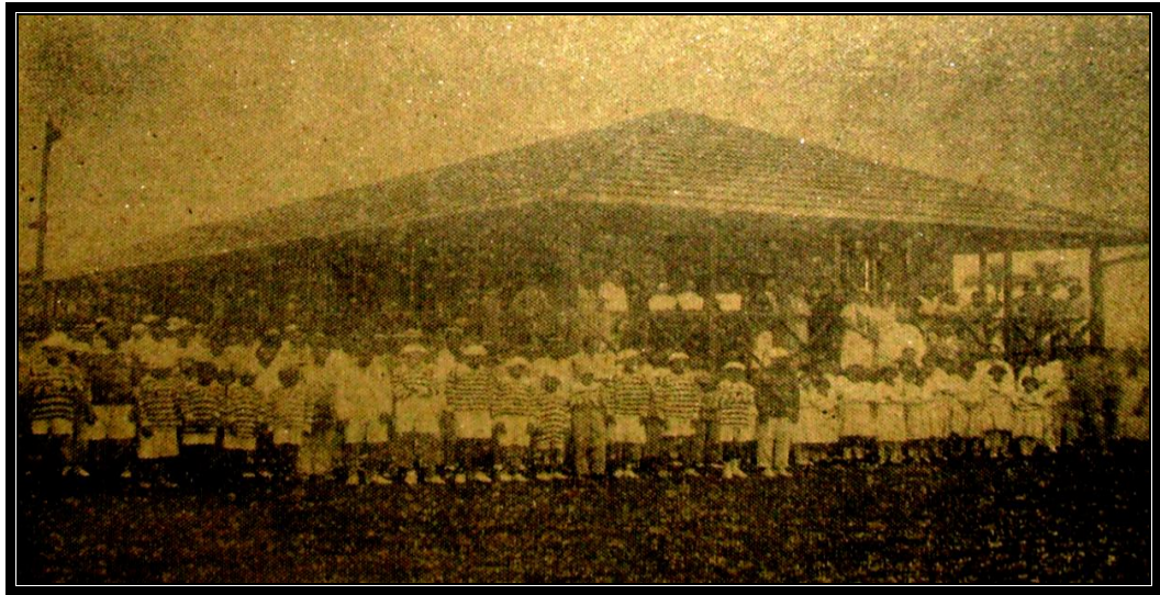
Figura 18: Pavilhão São Lázaro, inaugurado em 25 de dezembro de 1932, pela Sociedade Amazonense de Proteção aos Lázaros. Fonte: Sociedade Amazonense de Proteção aos Lázaros. Um ano de trabalho patriótico . 1932. p. 13.
