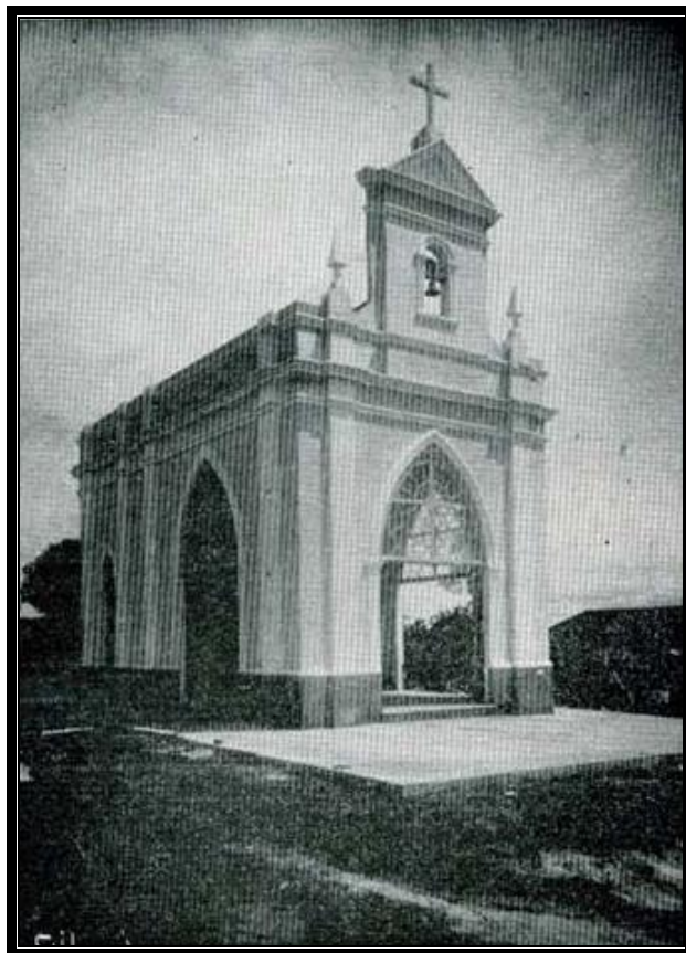
Figura 15: Igreja Nossa da Conceição após a construção. Fonte: UCHÔA, Samuel. A leprosanria de Paricatuba. p. 29.
