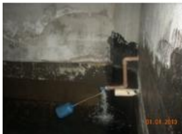
Figura 21 – Registro do tanque inferior
