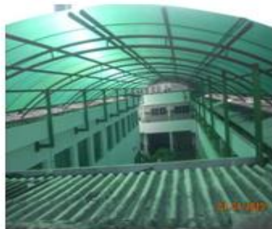
Figura 16 - Área de captação 6 Frente
