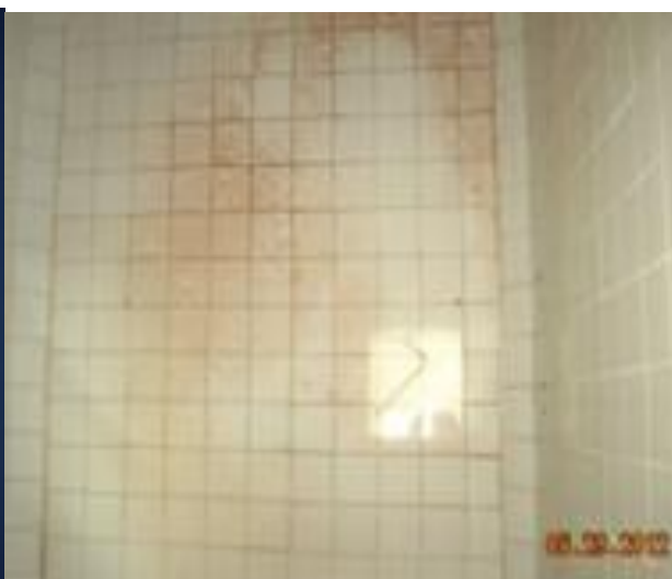
Figura 29 – Vista interna da cisterna 36 m 3
