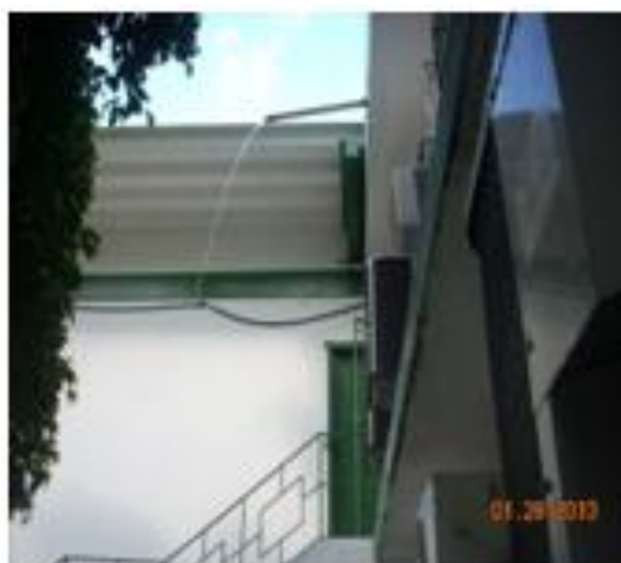
Figura 17 – Água da chuva Edificação 12
