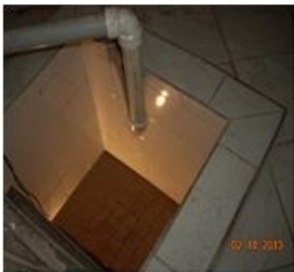
Figura 28 -Caixa d'água de 15 m 3
