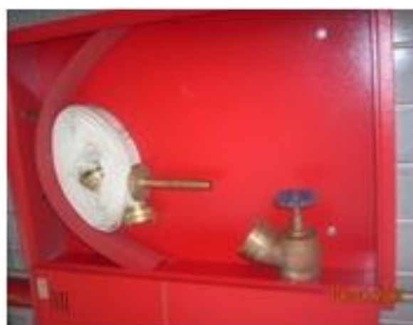
Figura 25 – Mangueiras para incêndio
