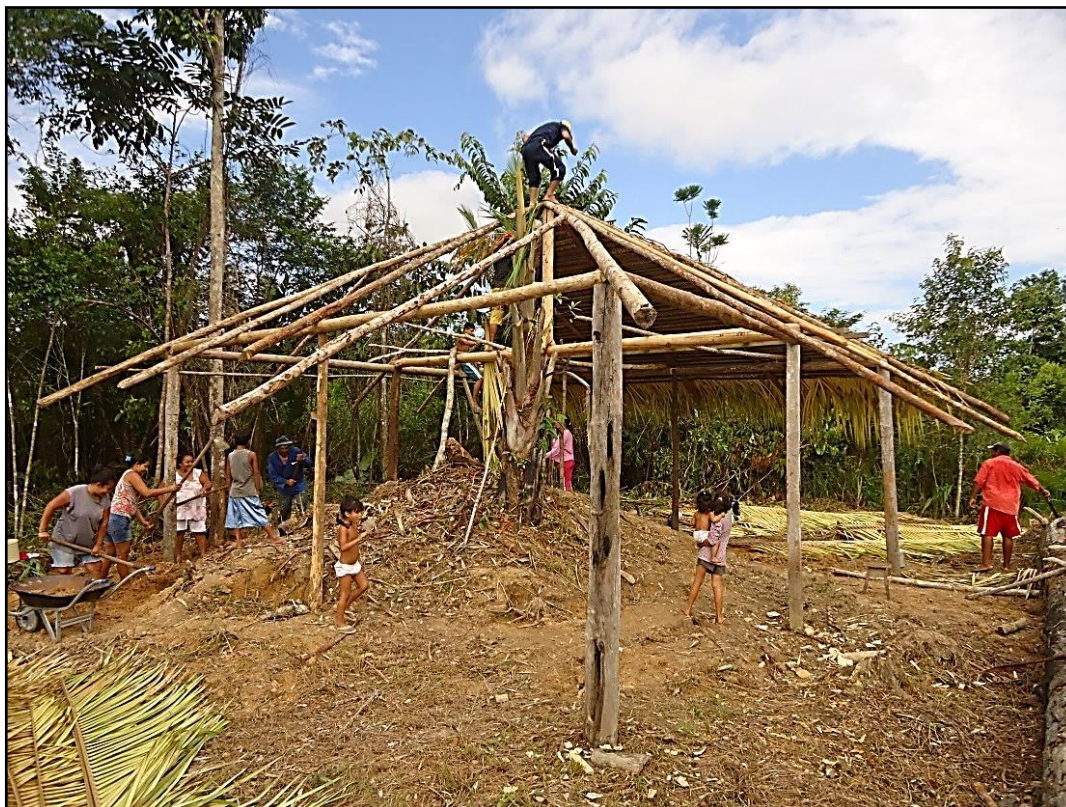
Figura 27 – Puxirão para construção da casa de farinha.
