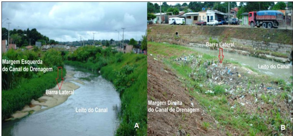
Figura 24: Barras laterais formadas no canal principal da microbacia do Passarinho: (A) Barra lateral composta por acúmulo de sedimentos naturais, (B) Barra Lateral tecnógena composta por sedimentos naturais e resíduos de origem antropogênica.
