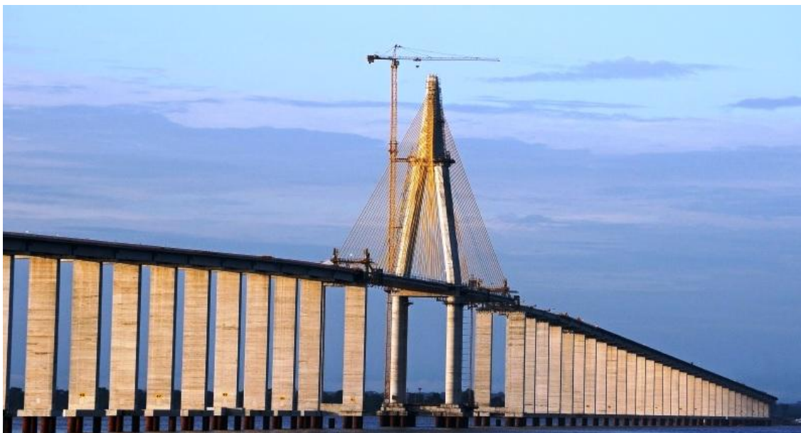
Figura 26: Ponte Rio Negro em construção.
