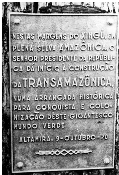
Figura 8: Placa de Bronze, marco do início das obras da BR-230 (Transamazônica). Fonte: Vogt (2004).
