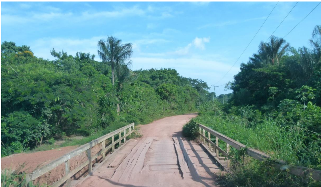
Figura 19: Ponte de madeira construída no ramal da Bela Vista Fonte: Louzada (2013)
