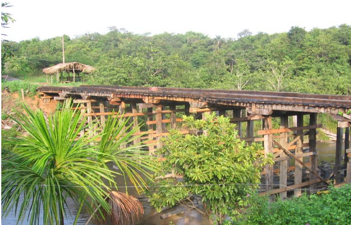
Figura 59: Ponte de madeira sobre um curso d'água na BR-319. Fonte: EIA-RIMA Relatório FINAL (UFAM, 2009).
