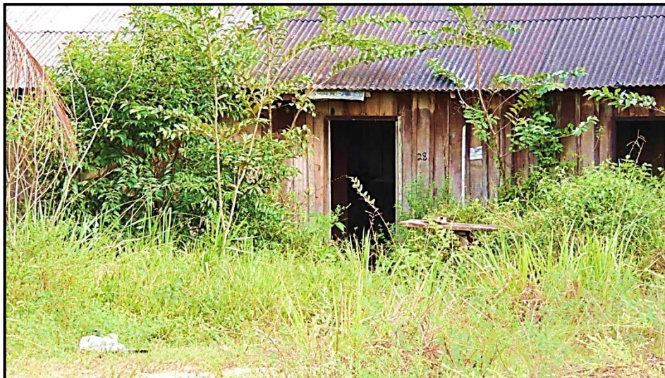
Figura 20: Casa com portas e janelas em lote abandonado na Vicinal 06
