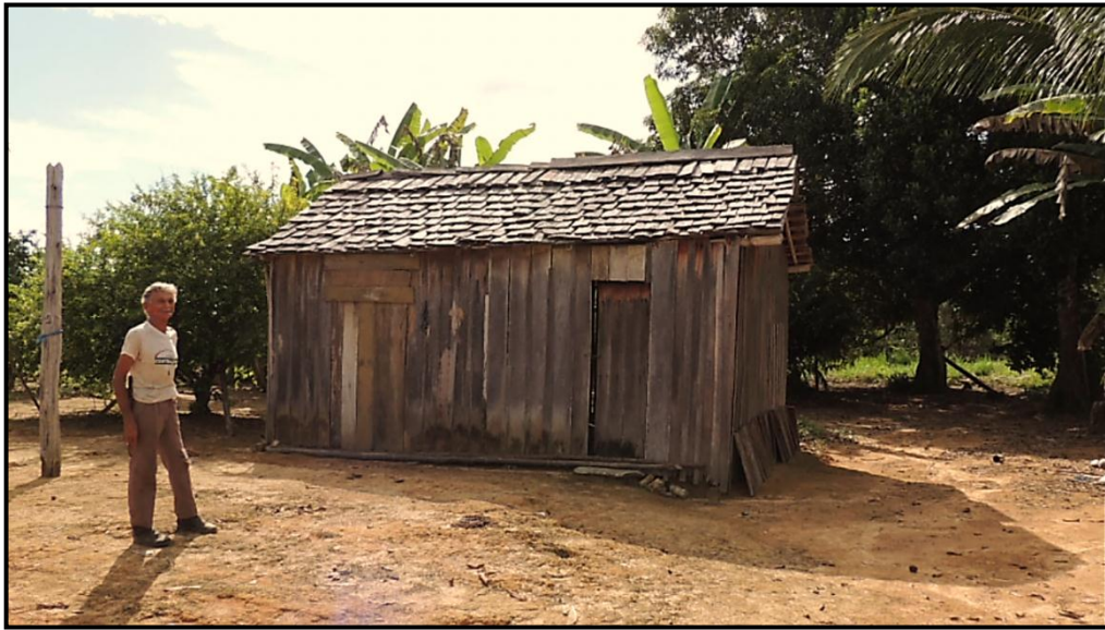
Figura 02: Barraco coberto com cavacos de madeira e João Baiano (ao lado)
