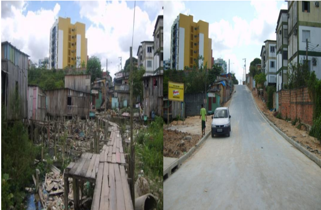
Figura 15: Assentamentos Precários Urbanos no bairro da União, trecho de Intervenção do PROSAMIM. Autor: Rodrigues, 2009. Autor: Santos, 2012
