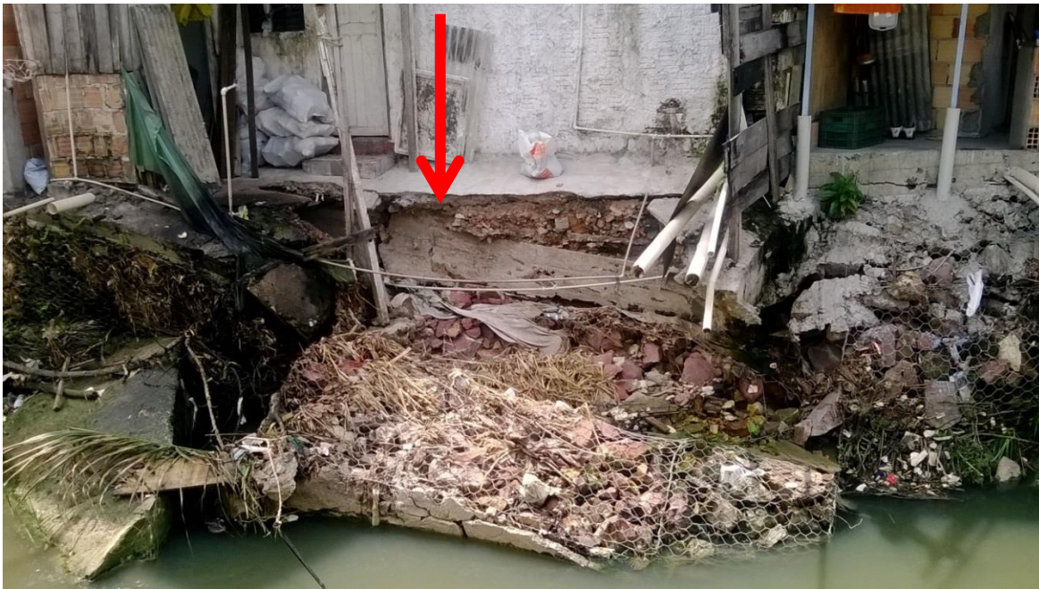
Figura 61: Foz, desmoronamento de residências. Autor: Santos, 2014.
