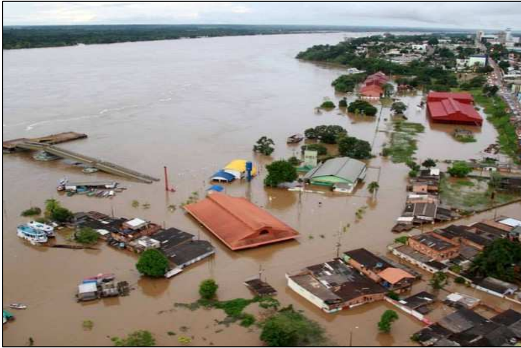
Figura 46: Centro histórico de Porto Velho inundado pelas águas da cheia do rio Madeira. Fonte: http://portalespigao.com.br/dilma-sobrevoa-areas-alagadas-da-capital-e-se-nega-falar-sobre-transposicao/ . Acesso em 24/07/2014.
