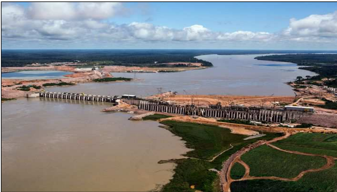
Figura 2: Hidrelétrica de Santo Antônio. Fonte: http://www.camargocorrea.com.br/grupo-camargo-correa/comunicacao/central-de-midia/fotos/engenharia-e-construcao.html . Acesso em 23/03/2014.
