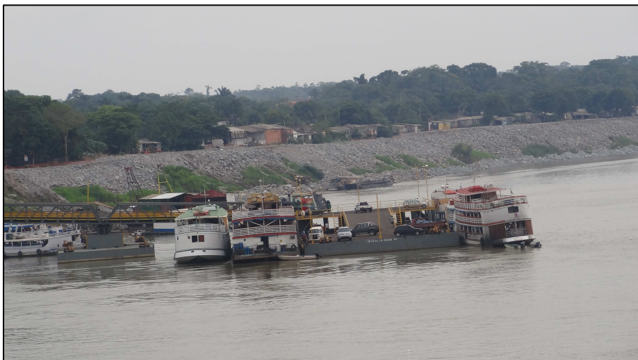
Figura 5: Contenção de rochas sendo colocadas às margens de Porto Velho para evitar o desbarrancamento. Trabalho de campo 2011. Foto: Gláucia Baraúna
