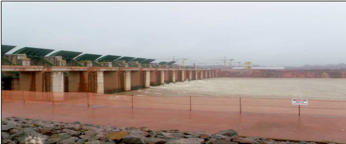
Figura 1: Hidrelétrica de Santo Antônio. Fonte: http://www.santoantonioenergia.com.br/ . Acesso em 23/03/2014
