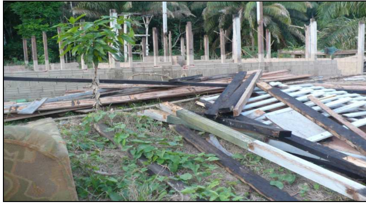
Figura 17: Casa do irmão de dona Neuzete. Os funcionários da SAE derrubaram a casa sem consentimento prévio do proprietário. Trabalho de campo 2011. Foto: Gláucia Baraúna.
