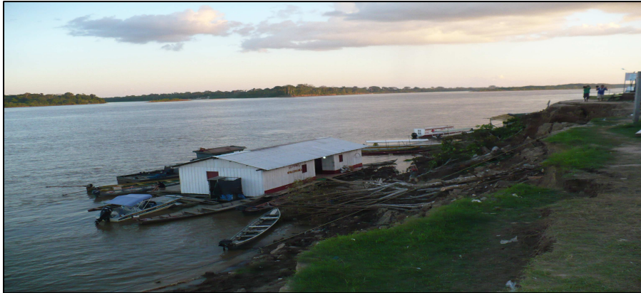
Figura 3: Desbarrancamento em São Carlos. Trabalho de campo 2011. Foto: Gláucia Baraúna
