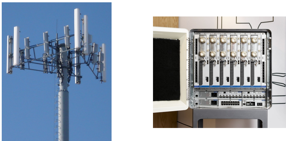
Figura 3.1: Topo de uma torre de rádio, onde os painéis funcionam como antenas (esquerda - fonte: http://www.radioinnovation.se/en/documents/ ), e um dispositivo de ERB modelo Ericsson RBS6000 (direita - fonte: http://comm.ae/ericsson-radio-base-station-milestone-achieved/ ).
