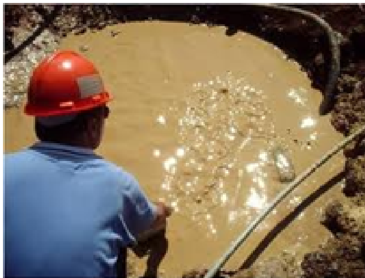
Figura 2.6. Exemplo de fluido de perfuração, o qual entre outras funções, ajuda a remover os fragmentos das rochas resultantes da perfuração.
