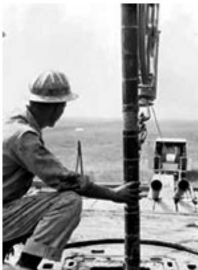
(a) Ferramentas de perfilagem sendo descidas no poço.
