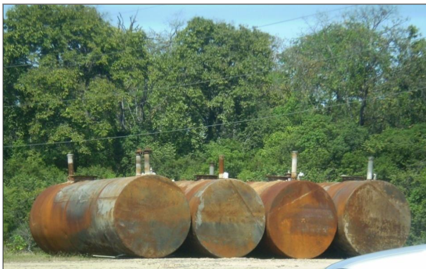
Figura 15: Tanques de subterrâneos de armazenamento de combustíveis desativados e abandonados ao lado de um posto onde foi coletada amostra de água na zona leste.
