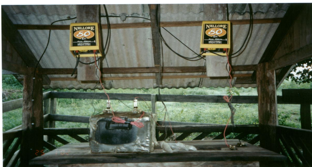
Fig.06 – Dispositivo para eletrificação de cerca, funciona com uma bateria de caminhão.
