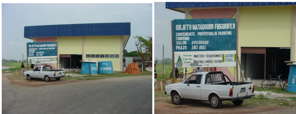
Fig. 17 – Obras do novo Matadouro Municipal de Parintins
