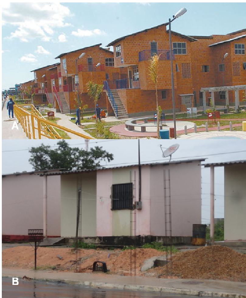
Figura 9 - (A) Vista geral do conjunto arquitetônico e paisagismo em conjunto central. (B) Vista da unidade habitacional em conjunto periférico.
