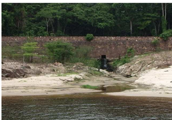
Foto 23 – Escoamento de esgoto do Tropical Hotel Manaus para o rio Fonte: Guglielmini, Luiza - 12/2003.
