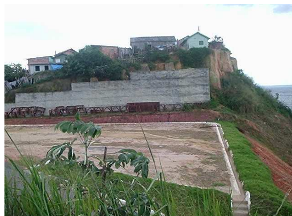
Foto 07 – Muro de contenção que ameaça as casas da comunidade, tornando a área de alto risco
