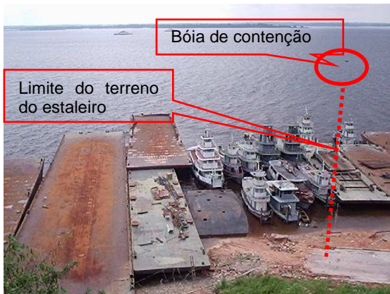
Foto 12 – Demarcação da área na água que não é respeitada na vazante Fonte: Guglielmini, Luiza - 01/2005.
