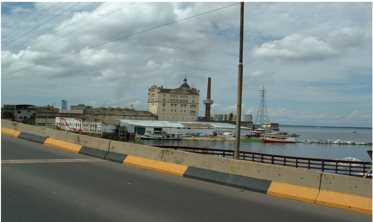
Figura 13 – Bairro de Aparecida antigo Plano Inclinado apresentando em destaque, o prédio da cervejaria Miranda Corrêa.
