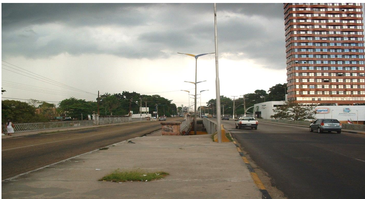
Figura 23 – Imagem da duplicação da Ponte dos Bilhares. No lado direito encontra-se o Shopping Center Millennium, local de consumo por meio do lazer. Foto: Pinheiro, 2007.
