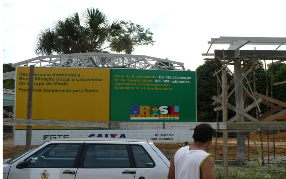
Figura 15: Início da execução das obras no PMNM
