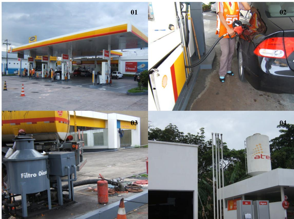
Figura 14 – 01 - posto de venda de combustível e sua infra-estrutura; 02 – abastecimento de veículos; 03 – abastecimento de tanques de combustível; 04 – respiro dos tanques
