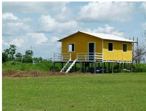
Figura 26: “Casa do INCRA”. Novembro de 2011. Foto de Ana Bocchini
