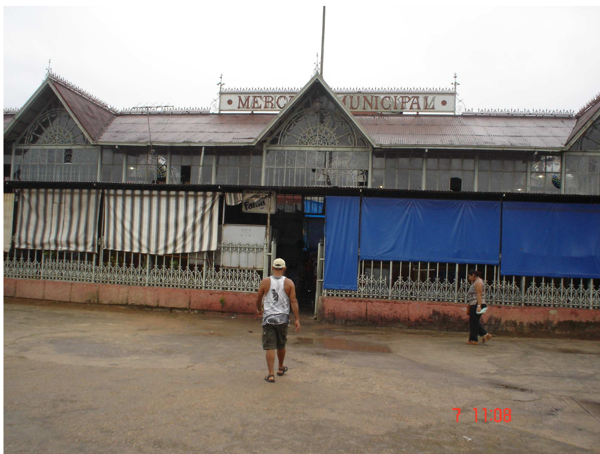
Figura 21 – Foto do Pavilhão da Tartaruga antes da reforma. Autor: Ronaldo Tavares da Silva, 2007.
