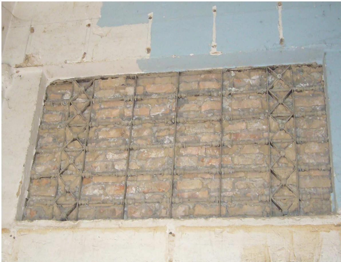
Figura 05 – Foto da grade em ferro fundido, de origem inglesa, com detalhes rendados. Encontrava-se emparedada. A partir do atual restauro fará parte da “rugosidade” do Mercado. Autor: Ronaldo Tavares da Silva, 2008.
