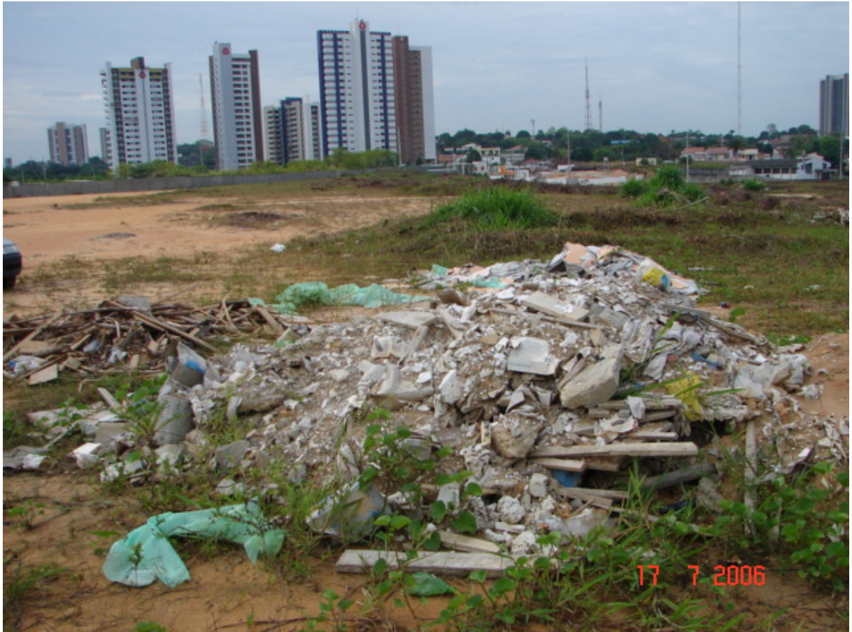
Figura 1 – Disposição clandestina de resíduos de construção em Manaus. Fonte: Cedida pelo Eng. Marcelos Marcião, SEMOSBH/PMM, 2006.
