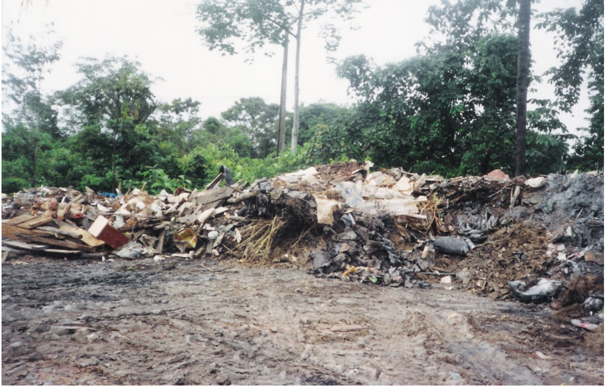
Figura 14 – Material separado para ser enviado ao aterro sanitário. Fonte: Cedida GEOTEC/UFAM, 2001.
