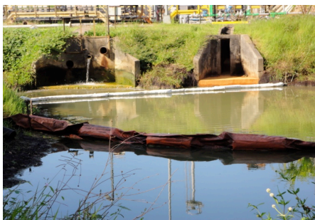
Figura 6. Dique de efluentes da Província
