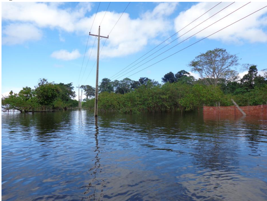
Figura 89: Rede de alta e baixa tensão instalada
