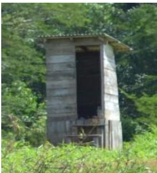
Figura 11: Banheiro/Catispera Fonte: Pesquisa de Campo 2013
