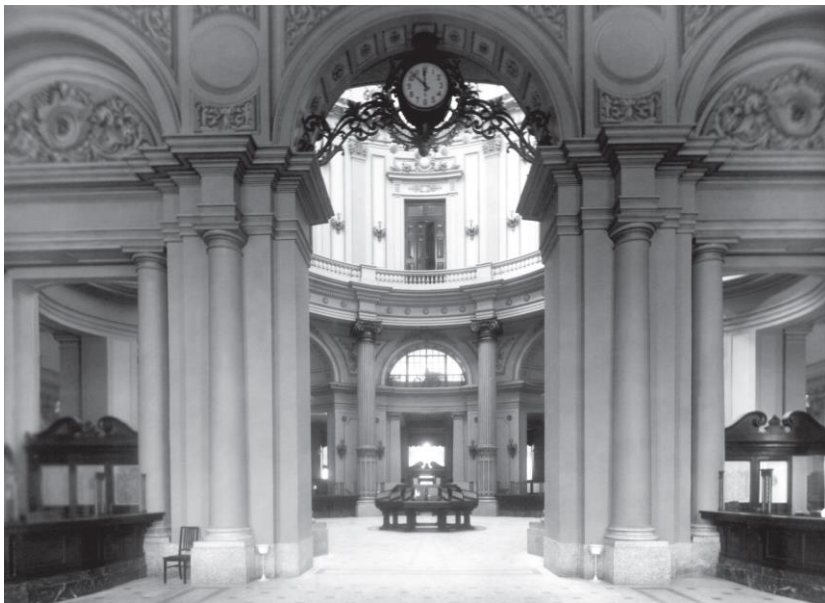
Figura 9 – Saguão na entrada principal do prédio do atual Centro Cultural Banco do Brasil, no Rio de Janeiro. Ao fundo, vista parcial da rotunda (1926).
