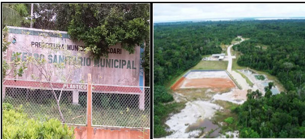
Figura 24: Fachada de entrada e vista panorâmica do Aterro Sanitário de Coari
