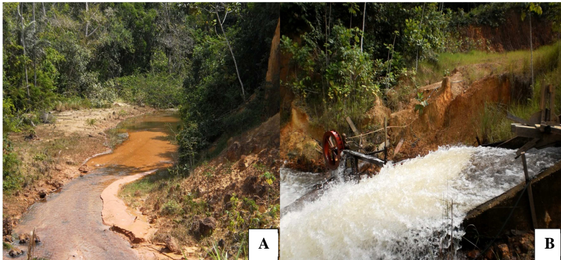
Figura 31 A; B: Processo de assoreamento e erosão a jusante da \mu CH São João. Fonte: Albano Neto, 2012.
