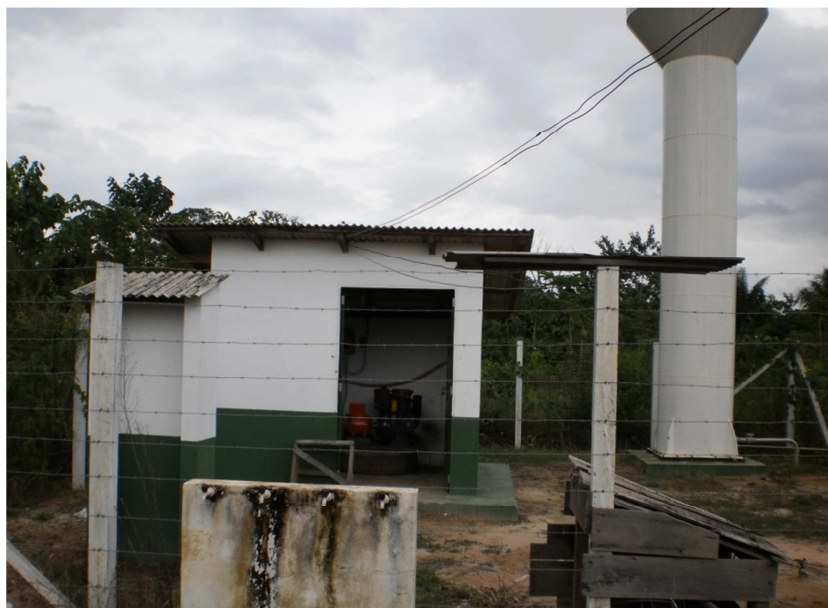
Figura 43: Micro sistema de Abastecimento de Água comunidade do Piranha.
