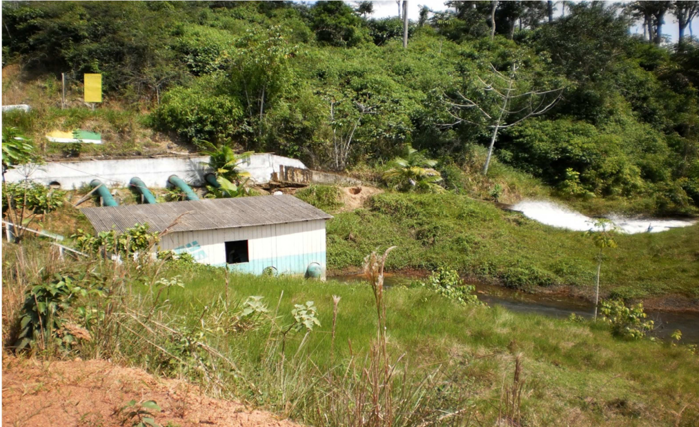
Figura 35: Área de Instalação da \mu CH Piranha.
