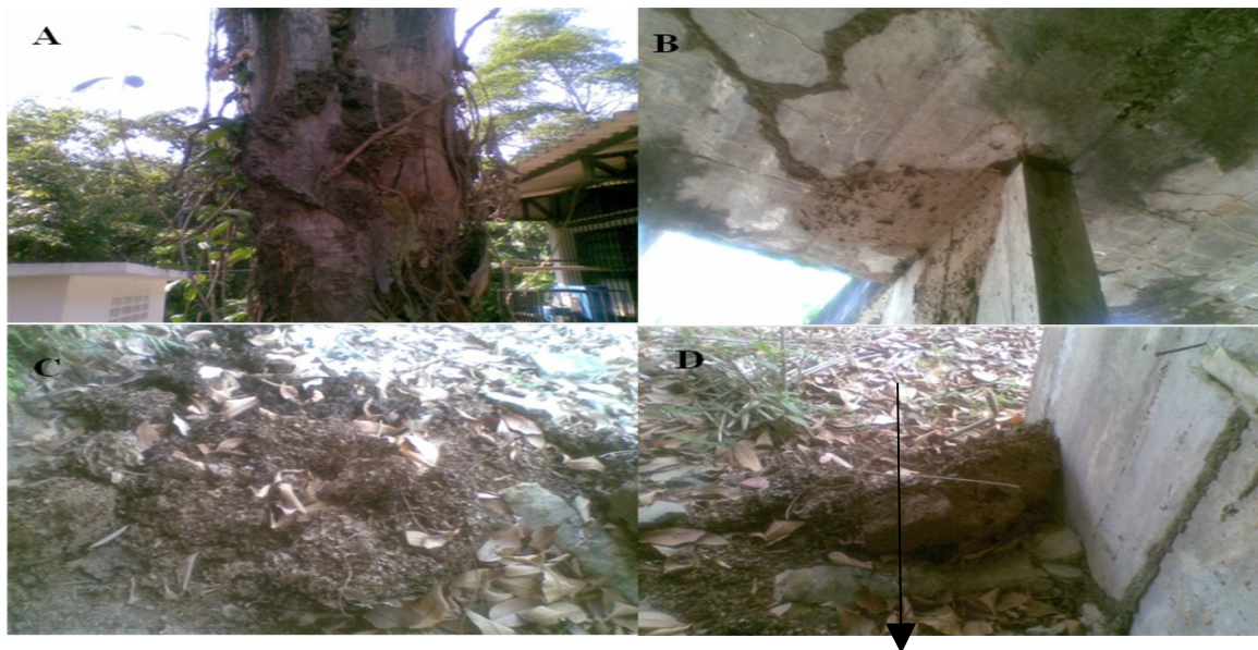
Figura 17- Desprendimento dos cupinzeiros de Nasutitermes corniger em árvores, tetos de edificações no Setor Sul do campus Universidade Federal do Amazonas aplicação da suspensão fúngica de Penicillium sp. na concentração de 1,0 \times 10^8 conídios/mL. (A) Caule da árvore após desprendimento do cupinzeiro (B) Teto do edifício após desprendimento do cupinzeiro (C) cupinzeiro recém caído da árvore (D) cupinzeiro desprendido do teto.
