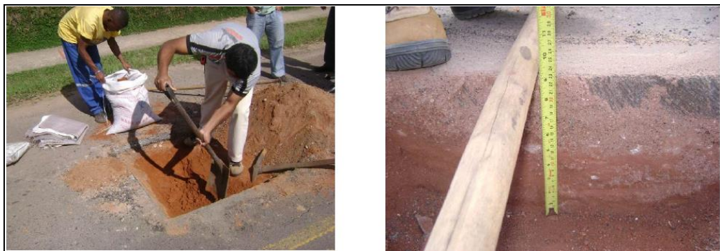
Figura 13 – Coleta de material e verificação da espessura da camada de revestimento.
