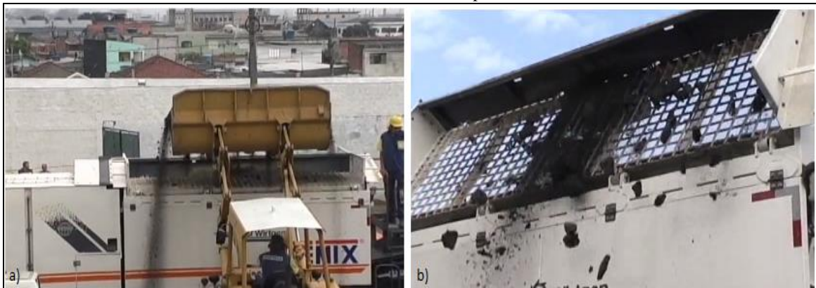
Figura 19 – a) Abastecimento do silo com pá carregadeira (material fresado); b) Peneiramento do fresado retido com diâmetro superior.
