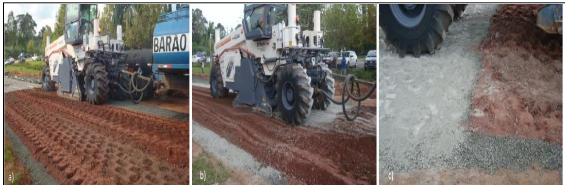
Figura 23 – a) e b) Recicladora WR 2500 S em operação; c) Camada com adição de CP II E 32 à esquerda e material reciclado à direita.
