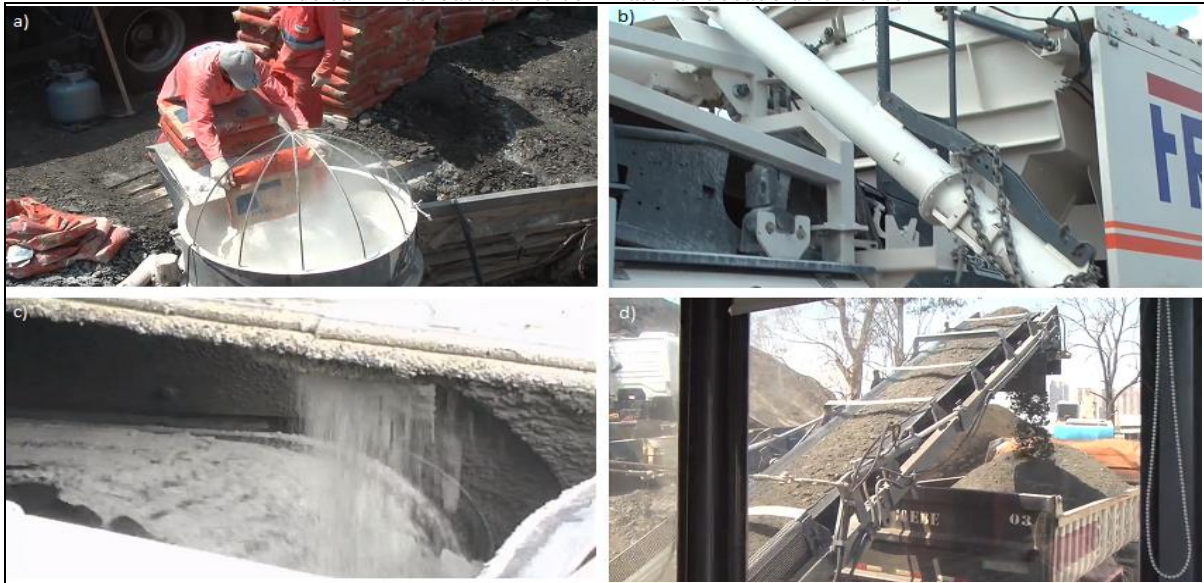
Figura 21 – a) Adição do CP II E 32; b) Rosca sem fim; c) Dosagem do cimento nos materiais; d) Carregamento de caminhão basculante com material dosado de cimento.
