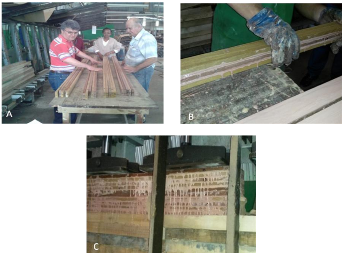
Figura 21: A- Sequências das lâminas B -Montagem das vigas C- Vigas na prensa Fonte: Dias, Aidson (2014)
