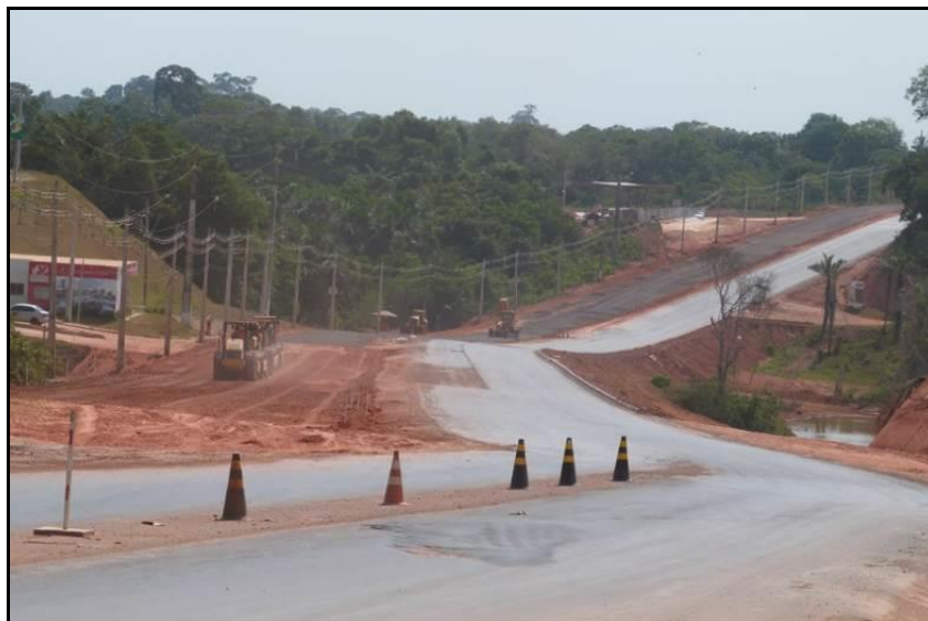
Figura 55. Obras de Duplicação da Rodovia AM-070 Fonte: Rodrigues et al., 2014.
