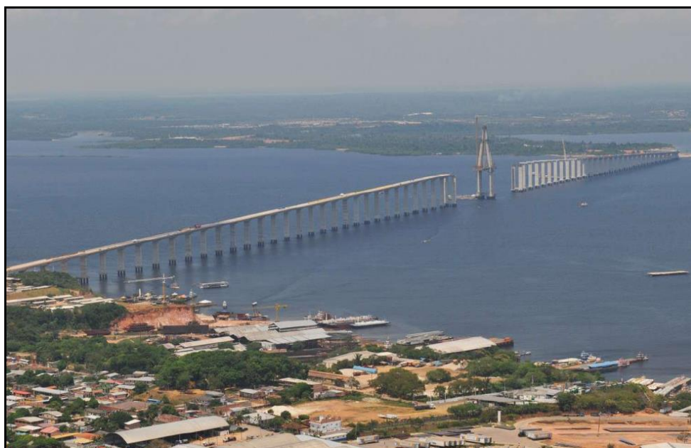
Figura 18. Ponte Rio Negro ainda em fase de construção. Fonte: Ibracon, 2010.
