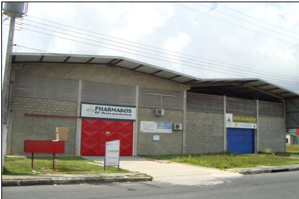
Figura 18 – O DIMPE tem a estrutura de um galpão para cada empresa que tem a vantagem de ter energia elétrica, internet e água a um baixo custo, sendo obrigação das empresas moldarem as instalações da maneira que desejam, ou seja, a infraestrutura interna é de responsabilidade das empresas. O prazo de permanência no DIMPE é inicialmente de 5 anos, podendo ainda ser entendido. Fonte: trabalho de campo, em julho de 2011.
