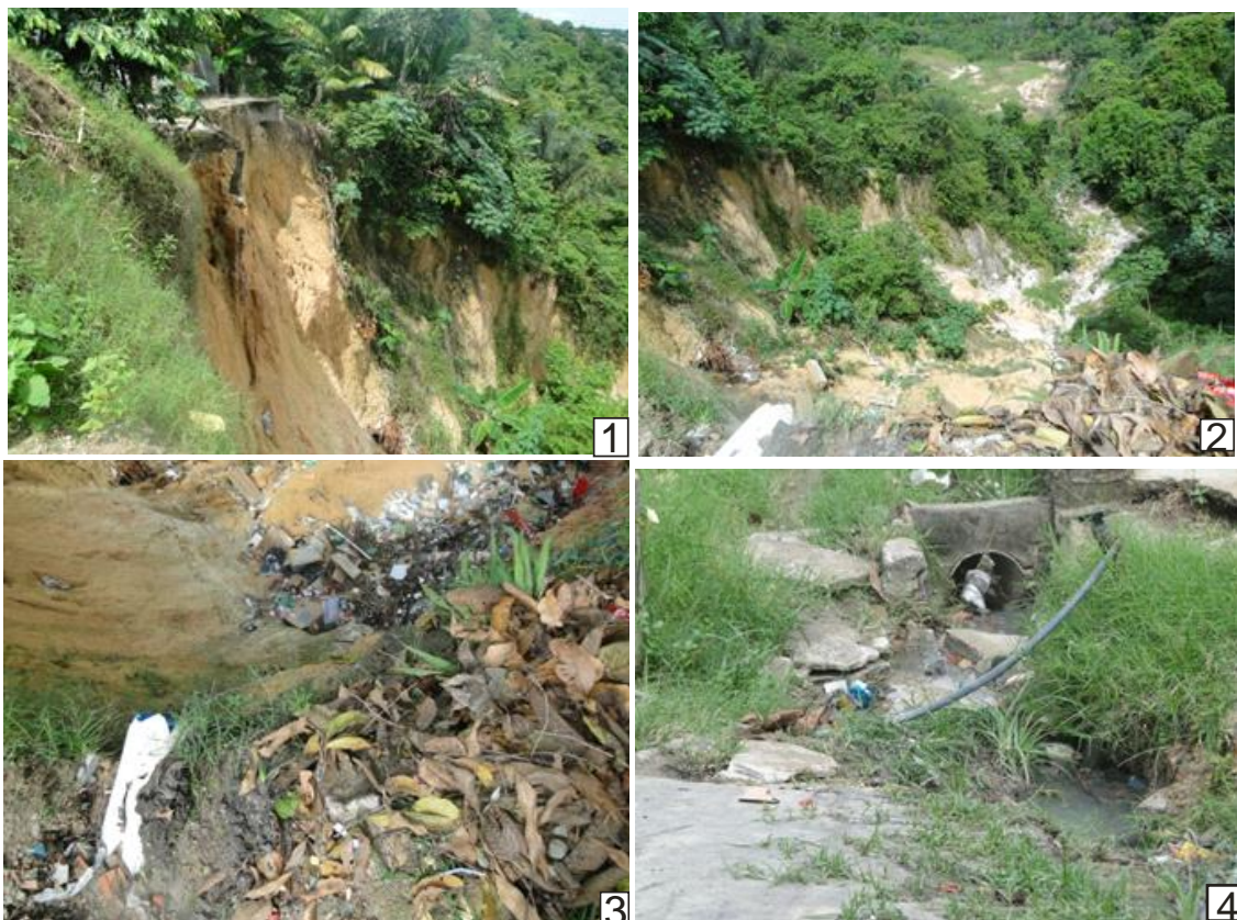
Figura 43 – Composta por 4 fotos do ponto Jt1. 1 – Imagem lateral de uma voçoroca. Observam-se restos da base de uma casa. 2 – Voçoroca na direção do fluxo, com igarapé assoreado no vale. 3 – Topo da voçoroca com lixo e entulho despejados pela população local. 4 – Obras de infraestrutura subdimensionadas, danificadas e ineficientes. Fotos do Autor.
