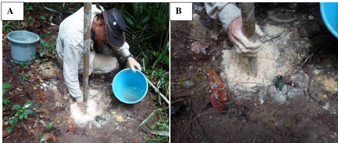
Figura 15 – A) Fotografia demonstrando o processo de inserção de areia proveniente da perfuração para pré-filtro; B) Selamento do piezômetro com bentonita.
