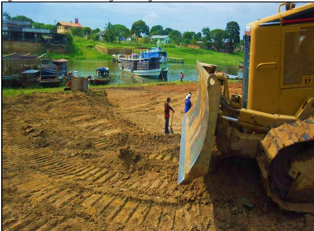
Figura 6: Aterramento das margens da Lagoa da Francesa.
