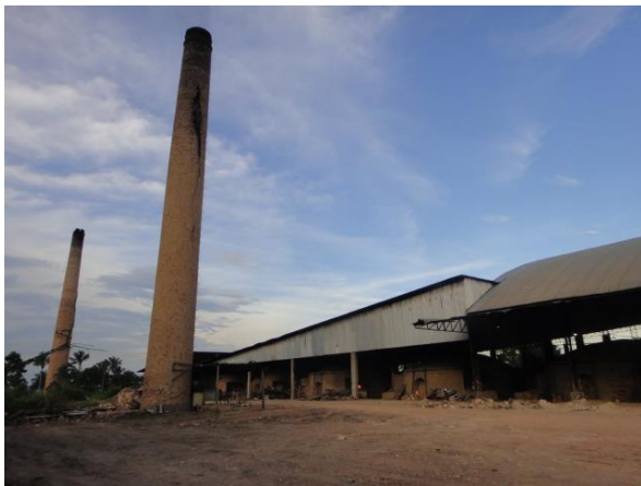
Figura 5 – Vista frontal do galpão de uma fábrica cerâmico-oleira FONTE: Pinheiro, 2013.
