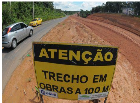
Figura 98 – Trecho em obras da AM – 070 FONTE: Mesquita, A Crítica, 2014.
