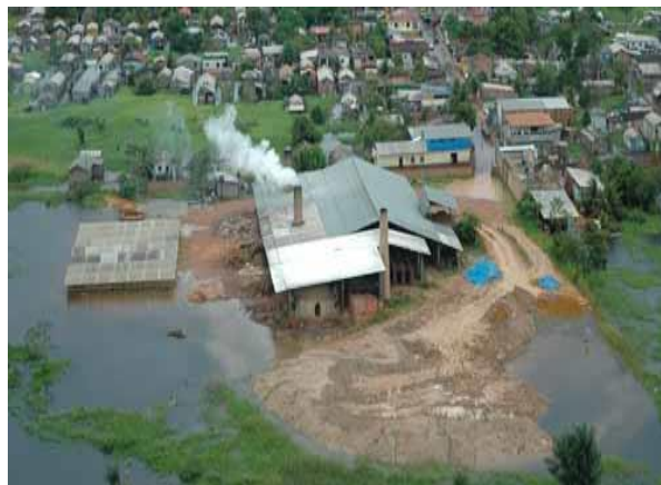
Figura 8 – Fábrica cerâmico-oleira alagada pela cheia em 2012 (visão panorâmica)
