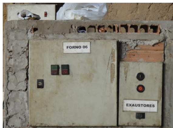
Figura 56 – Botões de acionamento dos exaustores FONTE: Pinheiro, 2013.
