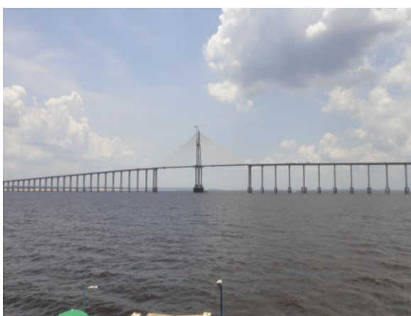
Figura 16 – Ponte Rio Negro FONTE: Pinheiro, 2013.
