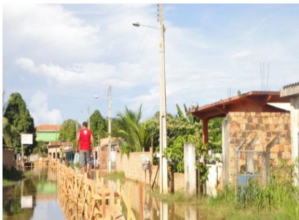
Figura 72 – Rua alagada durante a cheia de 2012 FONTE: Pinheiro, 2012.
