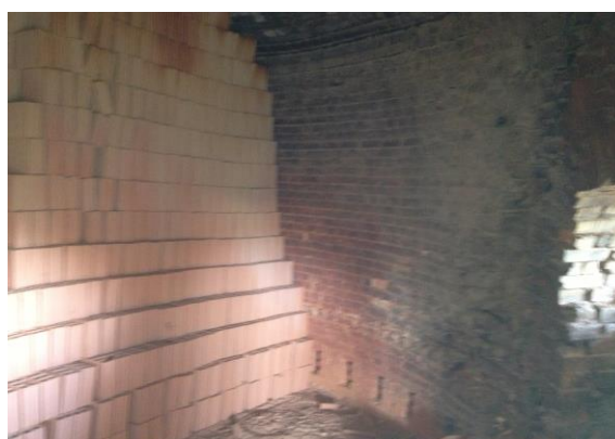
Figura 46 – Tijolos empilhados dentro do forno abóboda
