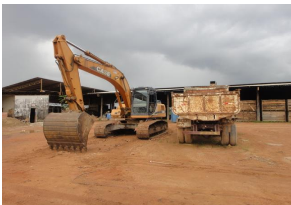
Figura 21 – Escavadeira hidráulica usada na extração de argila e caçamba empregada para o transporte FONTE: Pinheiro, 2013.
