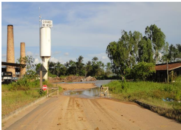
Figura 7 – Fábrica cerâmico-oleira atingida pela cheia em 2012
