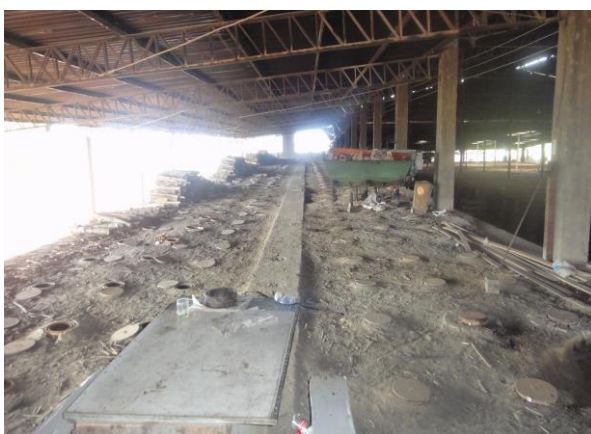
Figura 11 – Forno do tipo Hoffmann visto de cima FONTE: Pinheiro, 2013.
