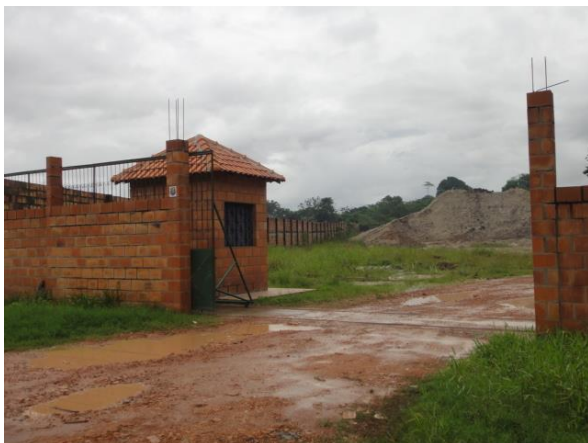
Figura 18 – Guarita de segurança (e portaria) na entrada da fábrica FONTE: Pinheiro, 2013.
