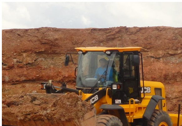
Figura 22 – Pá mecânica usada para transporte da argila FONTE: Pinheiro, 2013.
