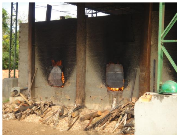
Figura 91 – Tampas colocadas nas bocas dos fornos
