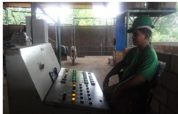
Figura 33 – Trabalhador operando o painel de controle das máquinas
