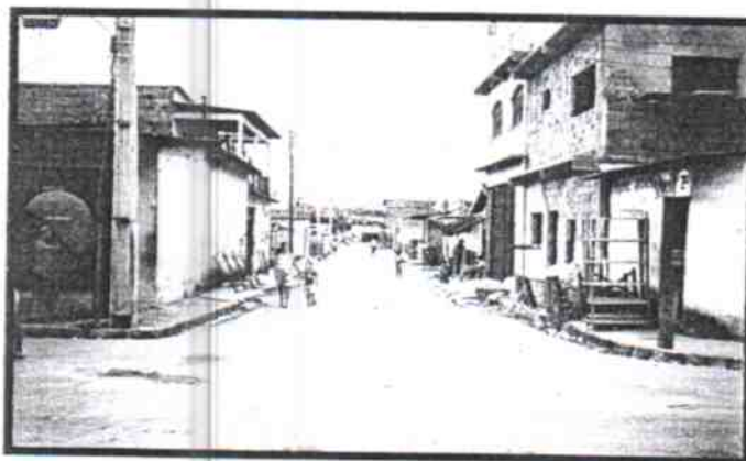
Figura 5.5 - Vista da principal rua do bairro, onde predominam as casas em alvenaria
