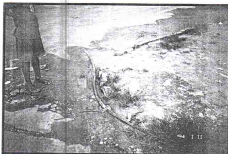
Figura 5.12 - Tubulação aparente de um serviço que não mais existe (Monte Sião/ Jorge Teixeira IV)
