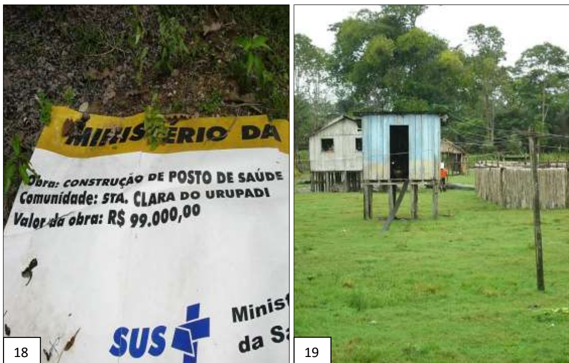
Figura 18 – Placa deteriorada pelo tempo sobre a construção de um posto de saúde sem funcionamento em Santa Clara do Urupadí, Maués. Figura 19 – Casa de motor de energia da comunidade São Bentes, em Parintins. FONTE: CAI Baixo Amazonas, abril/2011.
