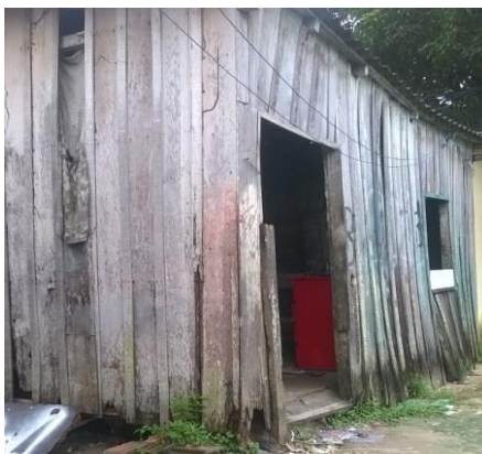
Figura 7-Casa de madeira Fonte: Arquivos Pessoais
