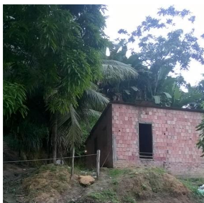
Figura 8-Casa de alvenaria Fonte: Arquivos Pessoais
